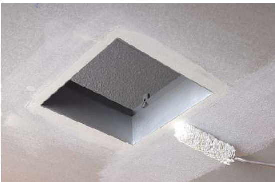
Na vlakschuren, overschilderen in gewenste plafondkleur. Het inbouwraam kan meegeschilderd worden.
