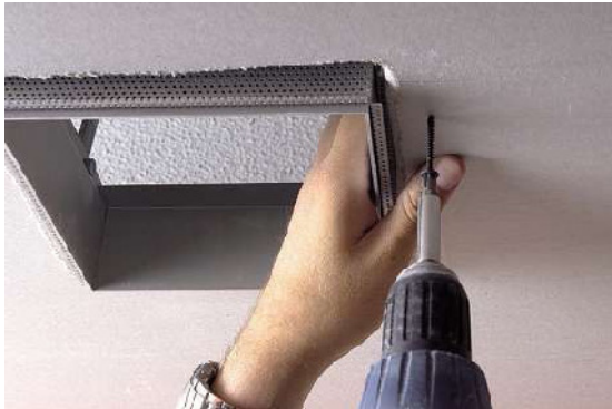
Inbouwraam in plafondopening vastschroeven in terugslagplaatjes boven op het vals plafond.
