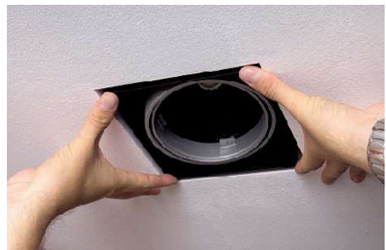
Frameless-armatuur met lampmodule bevestigen aan inbouwraam d.m.v. bevestigingsschroeven.
