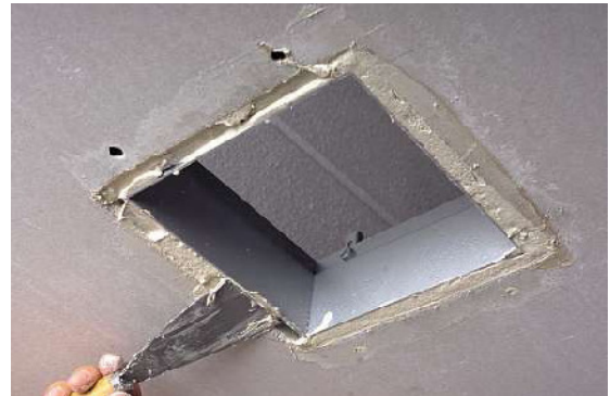
Opening tussen inbouwraam en plafond opvullen met vullende en overschilderbare pasta. Daarna afwerken.
